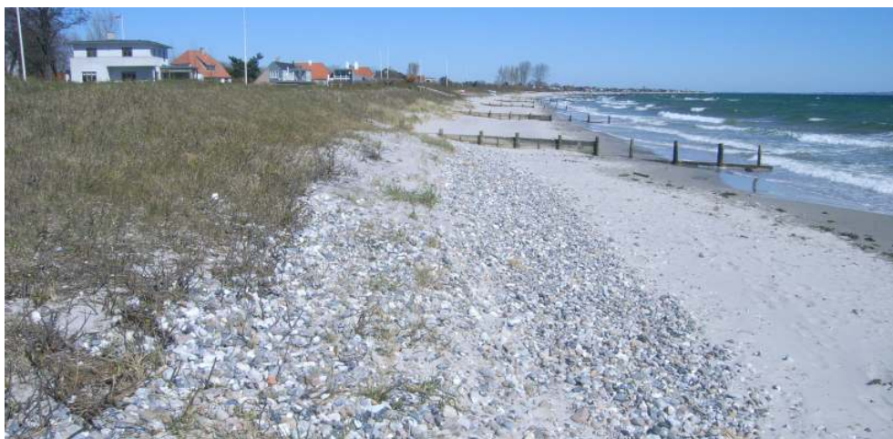
Figur 3-11 Ralstrand og små delvist nedbrudte træhøfder ved Rønnevej.
