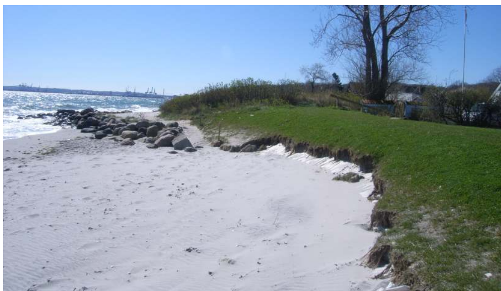
Figur 3-9 Beskadiget stenhøj og erosion af diget ved Platanvej
