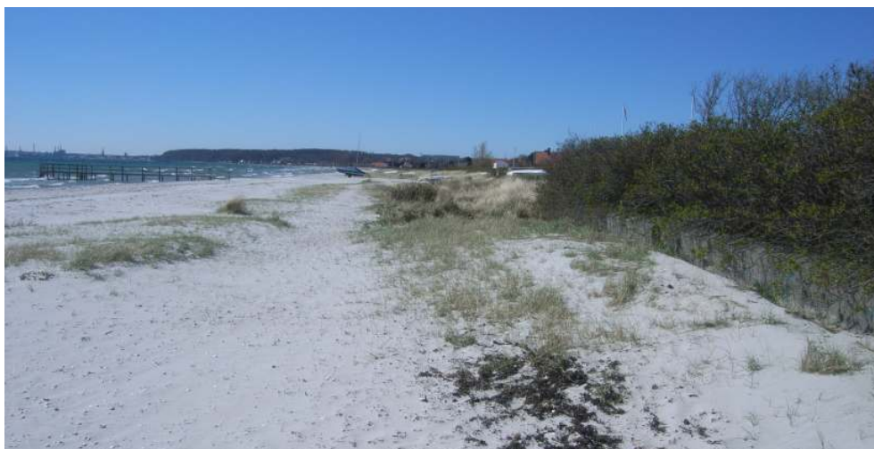
Figur 3-24 Bred sandstrand foran kystsikring. Også her er stranden akkumuleret op mod 25m i løbet af de seneste årtier. Små klitter er nu under dannelse foran muren, hvilket viser at storm højvande sjældent når så langt op mere.
