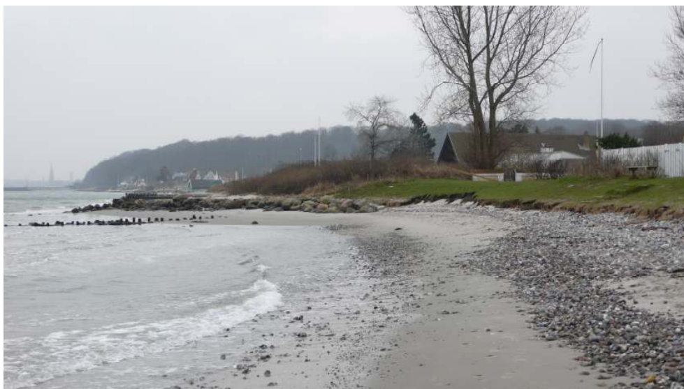
Figur 4-2 Høfde ved Platanvej og erosion af diget
