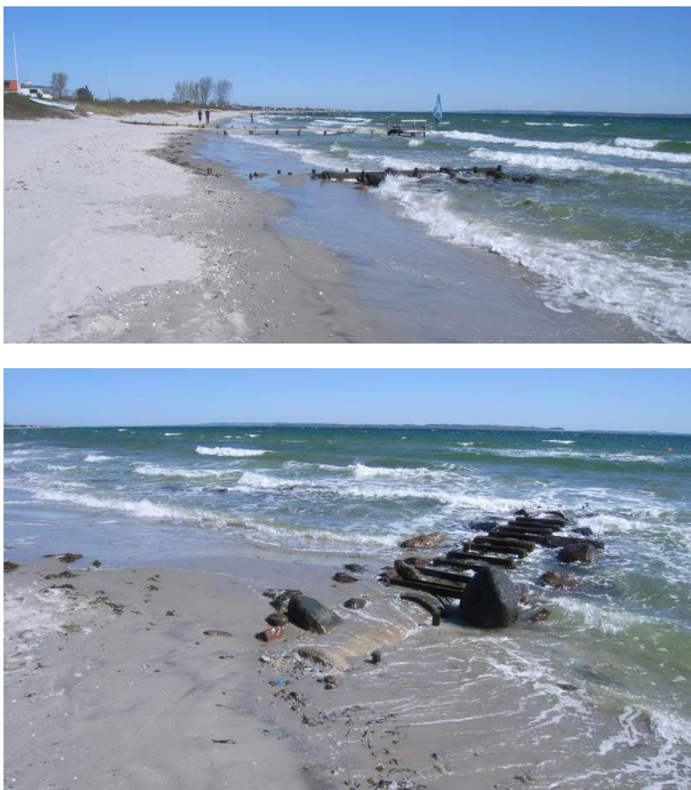
Figur 4-13 Eksempler på udløbsledninger langs kysten imellem Hospitalsgrunden og Bellevue.
