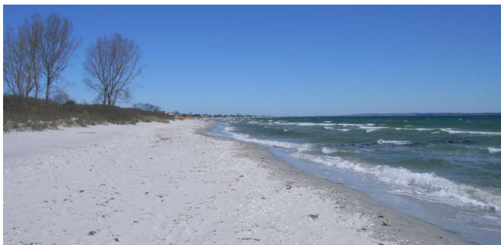
Figur 3-16 Sandstrand og udløbsrør ved Bellevue. Bemærk at der som resultat af stormerosion er en stejl skrænt ved digefoden.
