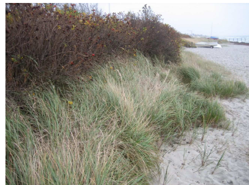
Billede 16 Diget er beskyttet med fliser eller støttemurselementer på hele strækningen
