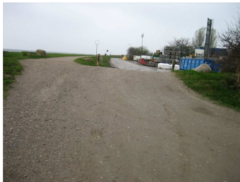
Billede 1 Ubelagt overkørsel af dige. Bør evt. befæstes
