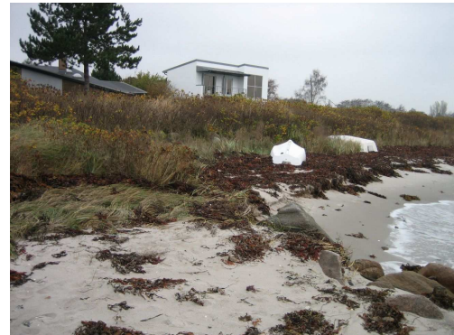
Billede 5 I læside erosionen bag høfden er der kun ca. 5 m fra tangkanten til diget
