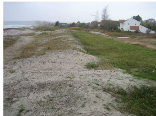
Billede 18 Den forreste del af diget er opbygget af strandsand. Midt på billedet ser det ud til, at man har bortgravet sand, hvorfor der muligvis er en vandvej ind i terrænet.
