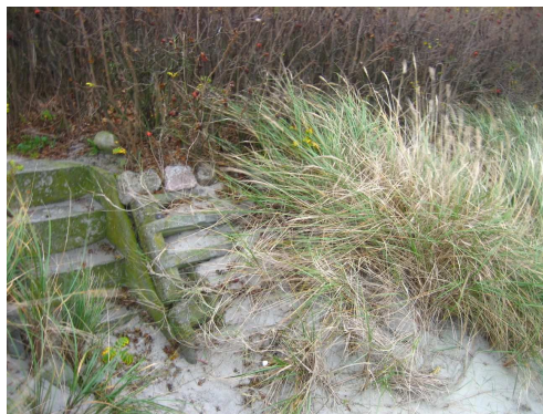
Billede 15 Stranden strækker sig helt op til diget, og der er anvendt støttemurselementer som beskyttelse af digets forside.
