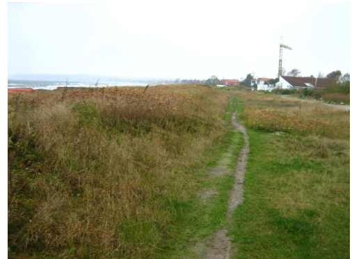
Billede 8 Gangsti bag diget, på det meste af strækningen
