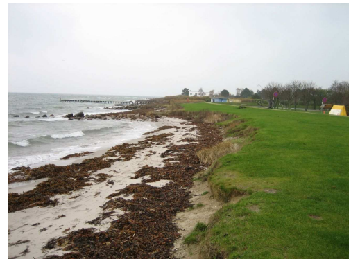
Billede 2 Kysten er under svag erosion, men diget er meget bredt og forventes ikke brudt af erosion indenfor en 50 års tidsramme.
