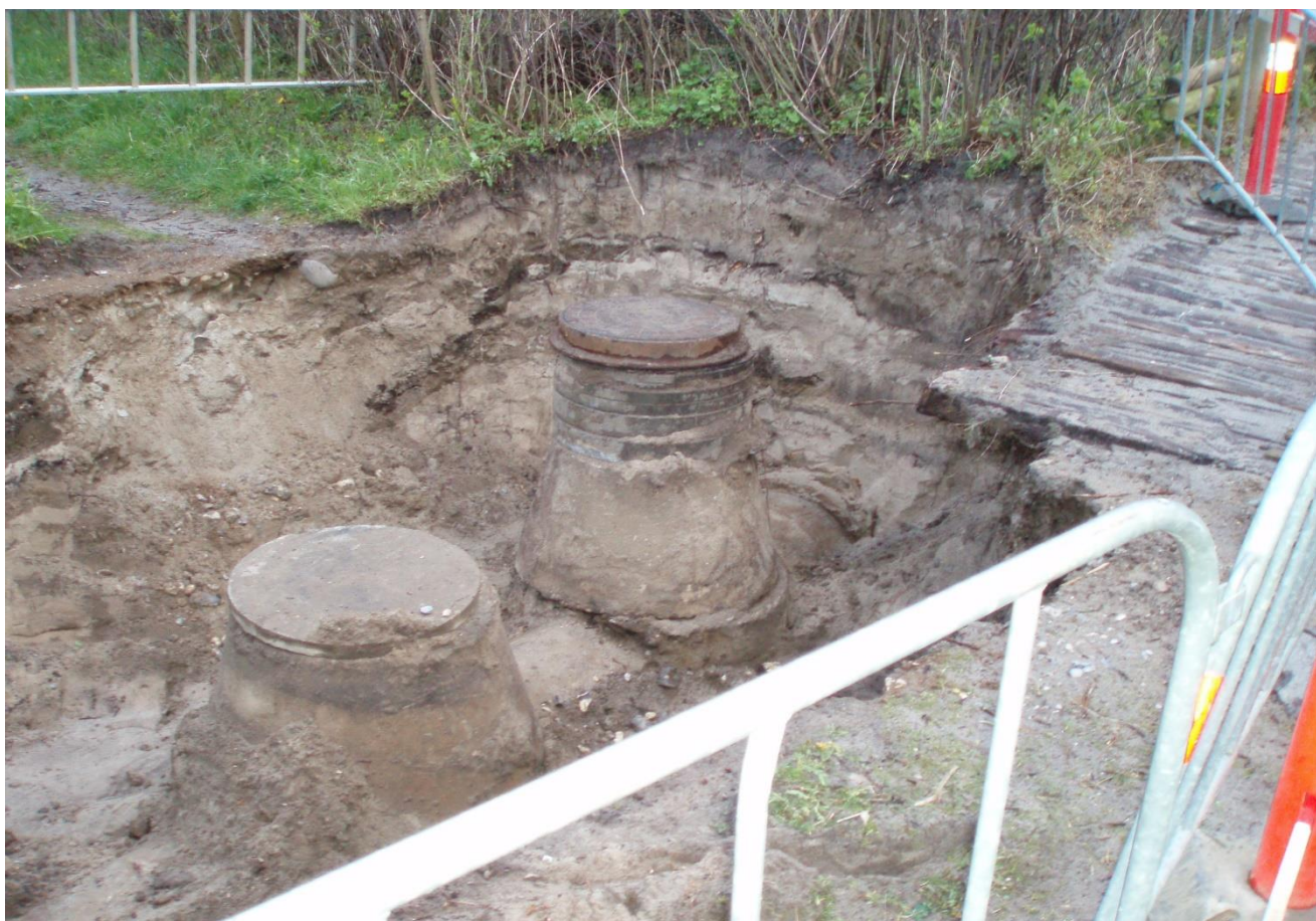
HYLDEVEJ: Udgravning ved gamle brønd, hvor denne erstattes med ny brønd med klap.
