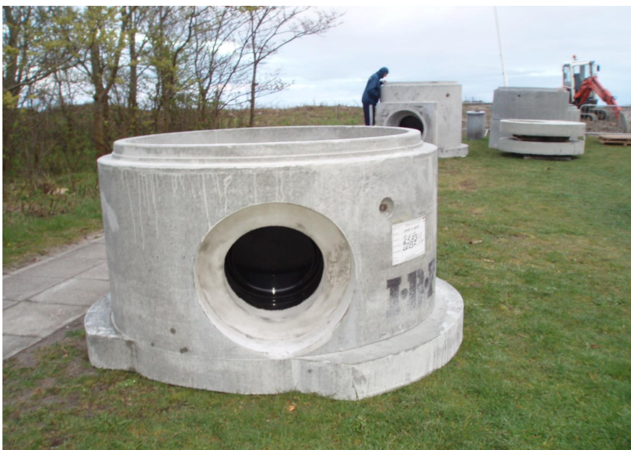
Brøndrør med klap til senere montage på Hyldevej. Steffen, der er høj, kan kun lige kigge ned i brøndrøret.
