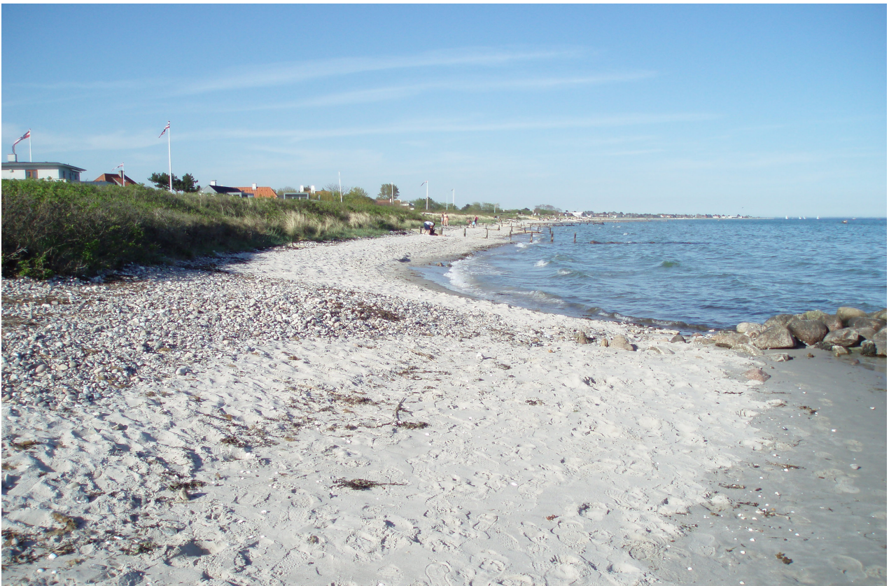
Billede 3: Ved Rønnevej, stenkastningen om udløbet giver erosion op mod digefoden mod NØ
