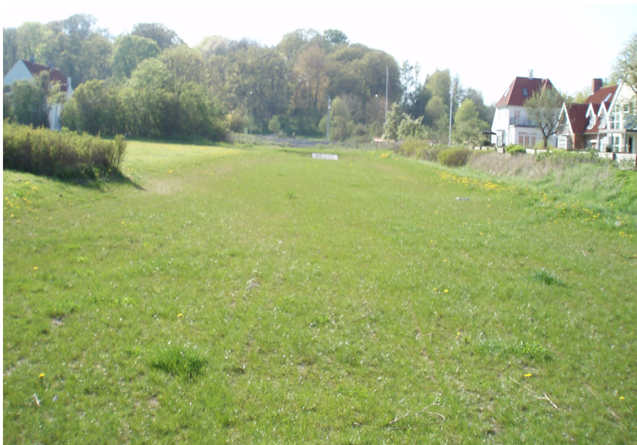
Billede 1: Nye overløb for bækken taget langs fløjdiget mod jernbanen.
