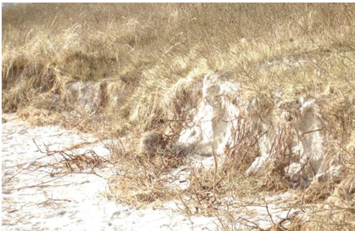
Erosion af digefod efter storm/højvande (Bellevue, Januar 2007)..
