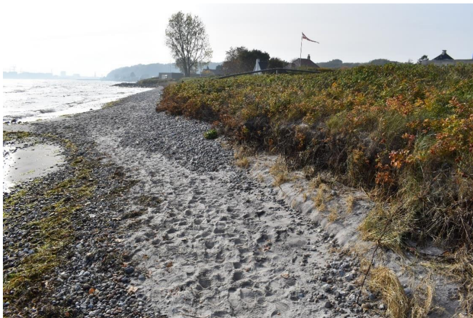
Foto 3 Kysten lige nord for Rønnevej (set mod syd) med læsideerosion i digefoden som konsekvens af forstærket stensætning omkring udløbsledning i 2015.
