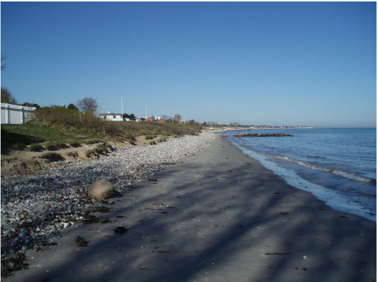
(2) Stranden mellem Platanvej og Rønnevej. Den store stenkastning ved røret ved Rønnevej i baggrunden.
