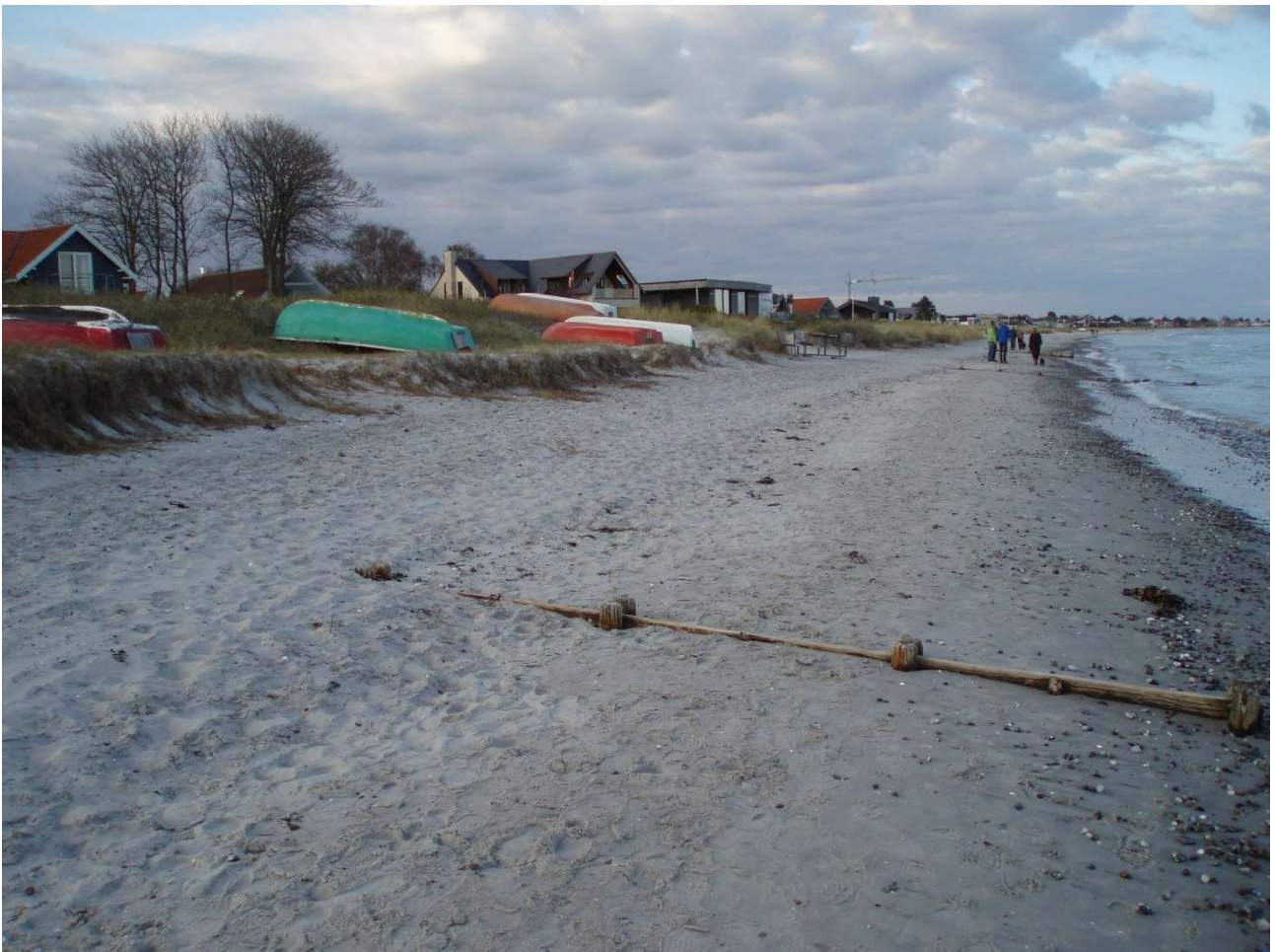
(4) Der er taget lidt af højden på forstranden, de gamle høfder er blottet, skarp kant opad på stranden
