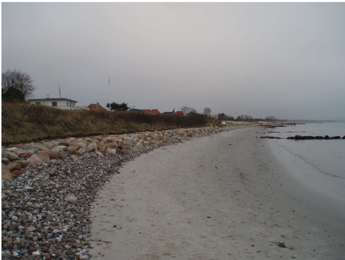
(5) Rønnevej med stenbeskyttelsen for diget. Der er ret pænt med sand på stranden.
