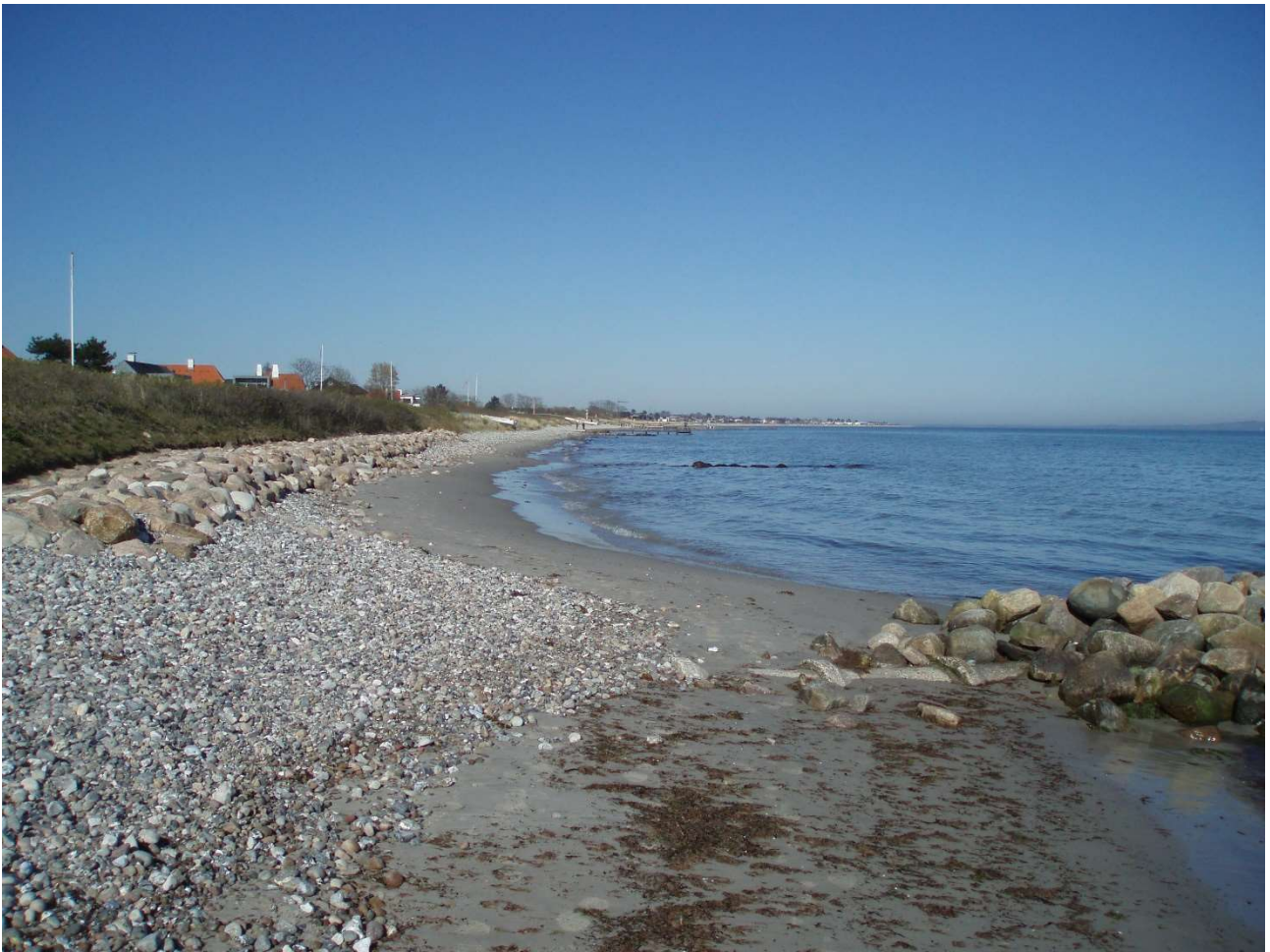
(3) Stenbeskyttelsen af diget ved Rønnevej. De store stenkastninger ud i vandet medfører erosion.
