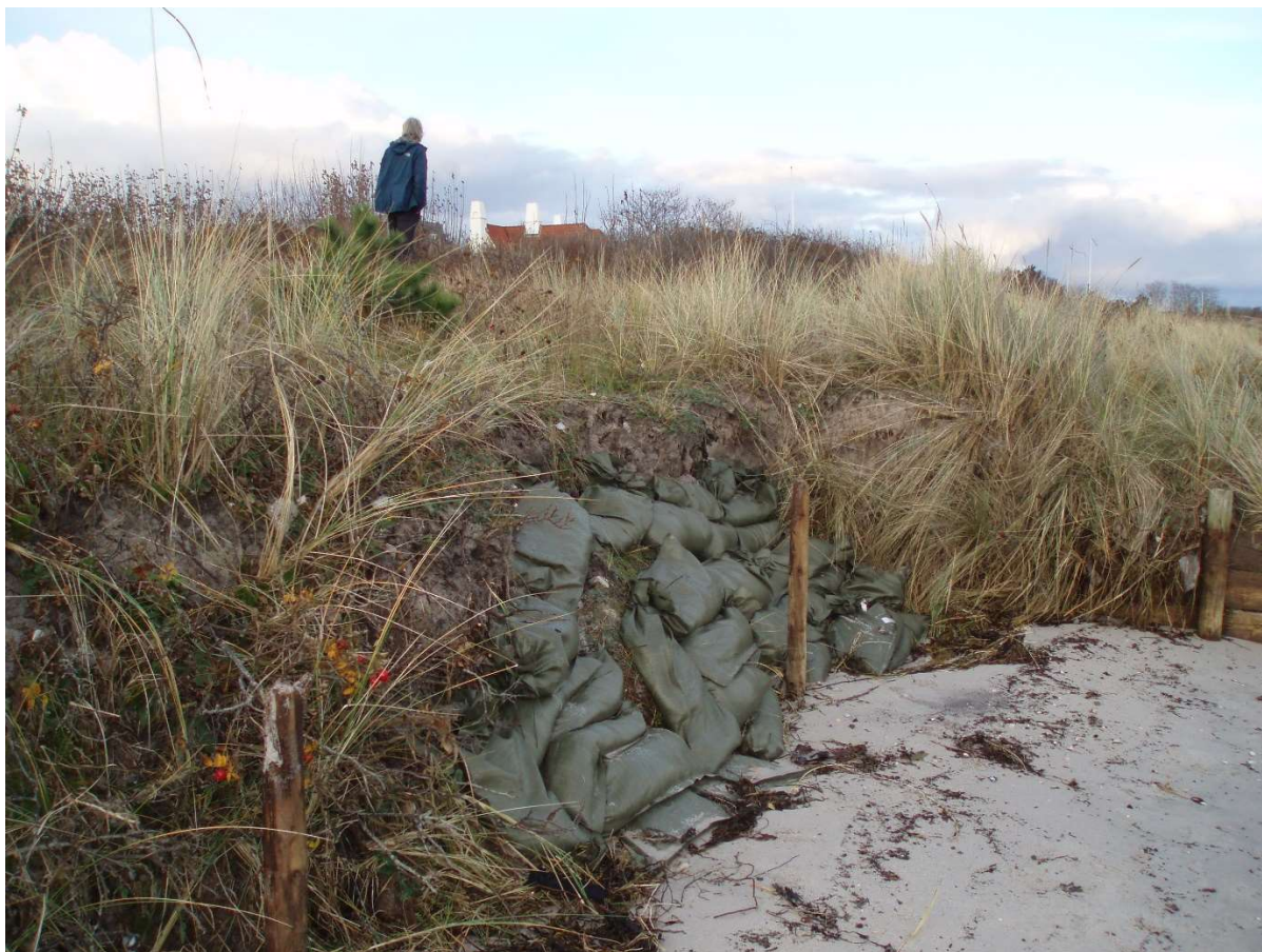
(6) Hyldevej, der står en skarp kant i sandet foran diget på forstranden. Det drejer sig ikke om diget. Hyldevej har lagt sandsække på, men det er ikke nødvendigt, er blot strand/klit. Digefod ved person!
