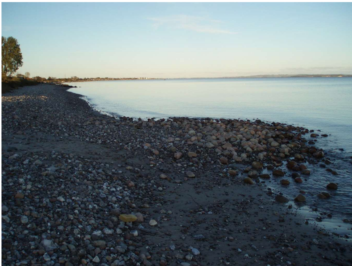
(2) Overløbet af LU 23g billede et par uger tidligere . Stenene er flyttet som en tunge ud i vandet.
