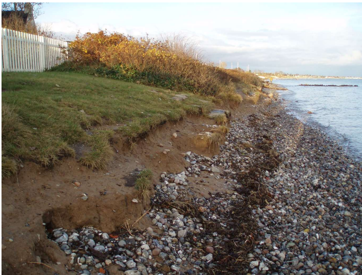
(5) Platanvej mod Rønnevej. Digefoden påvirket og let eroderet.
