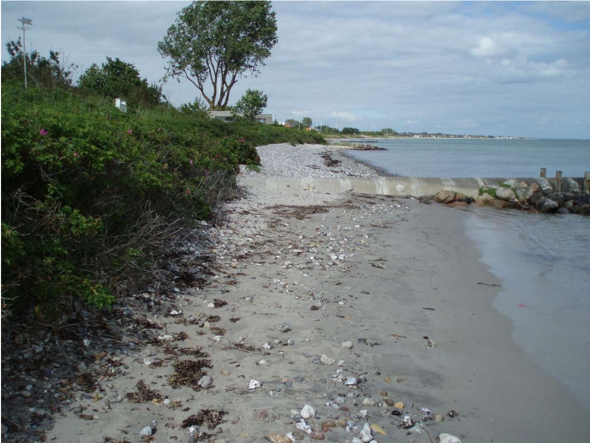
(3) Erosion ved LU 23g , digefoden påvirkes og kan let eroderes.
