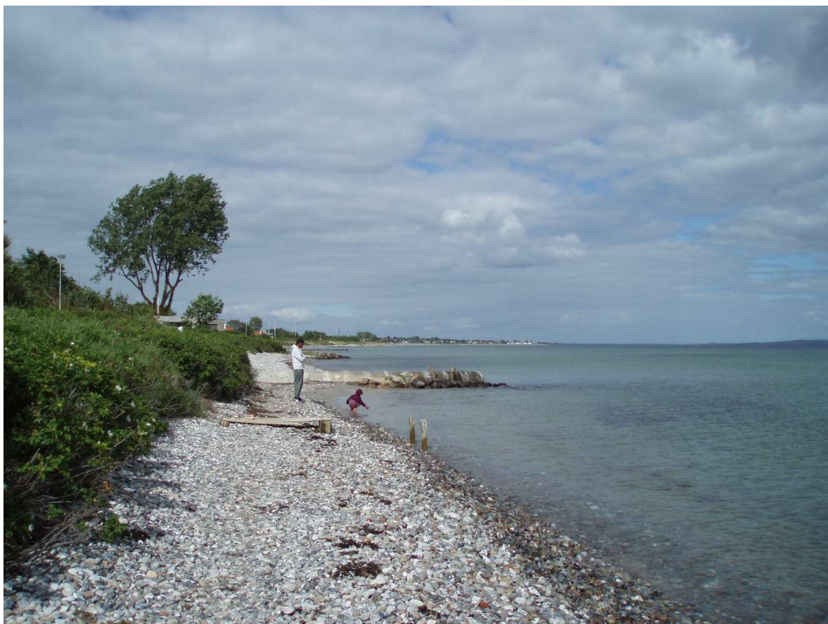
(2) Erosion ved LU 23g.
