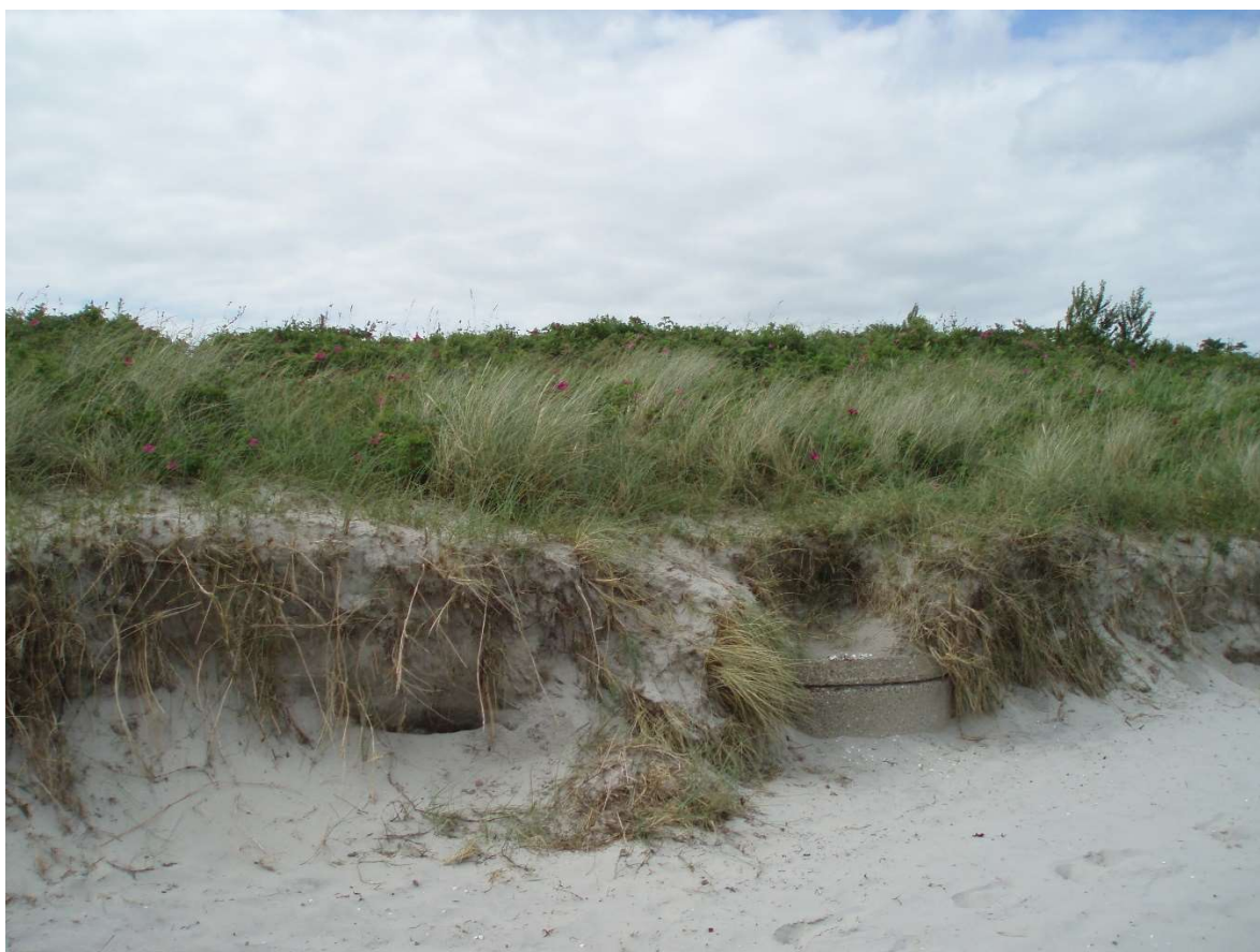
(8) Bellevue kloakdæksel på udløb vasket fri ned til niveau svarende til for flere år siden. En del sand påny retur.
