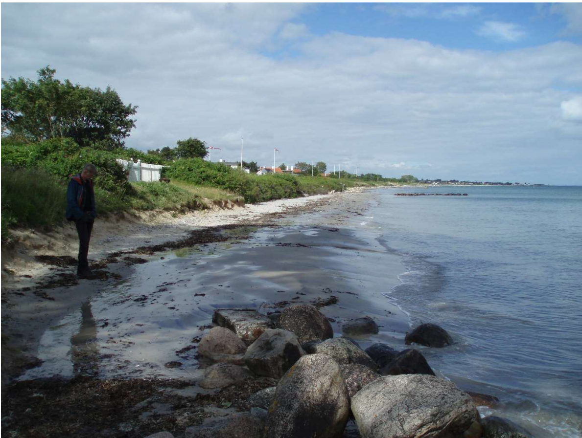
(4) Pæn høj strand (vandstand + 40 cm ) og eroderet dige ved Platanvej.
