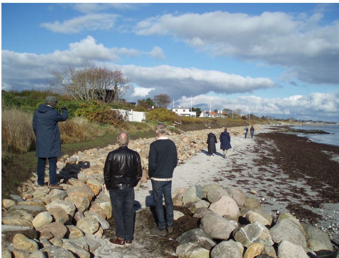
(3) "Pynten" ved Platanvej mod Strandvænget med anlagt stenbeskyttelse.
