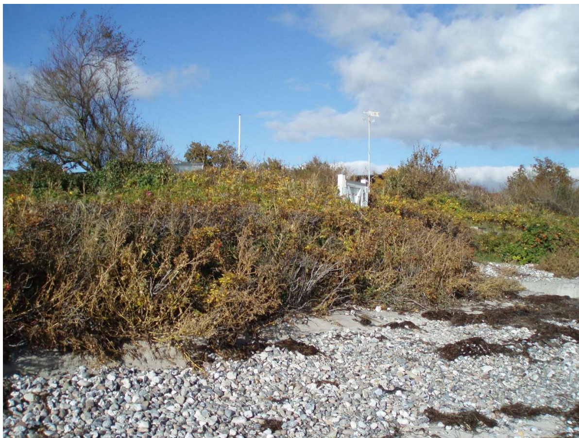
(2) Tidligere erosion af diget sydvest for LU 23g er fuldstændig fyldt op og dækket.
