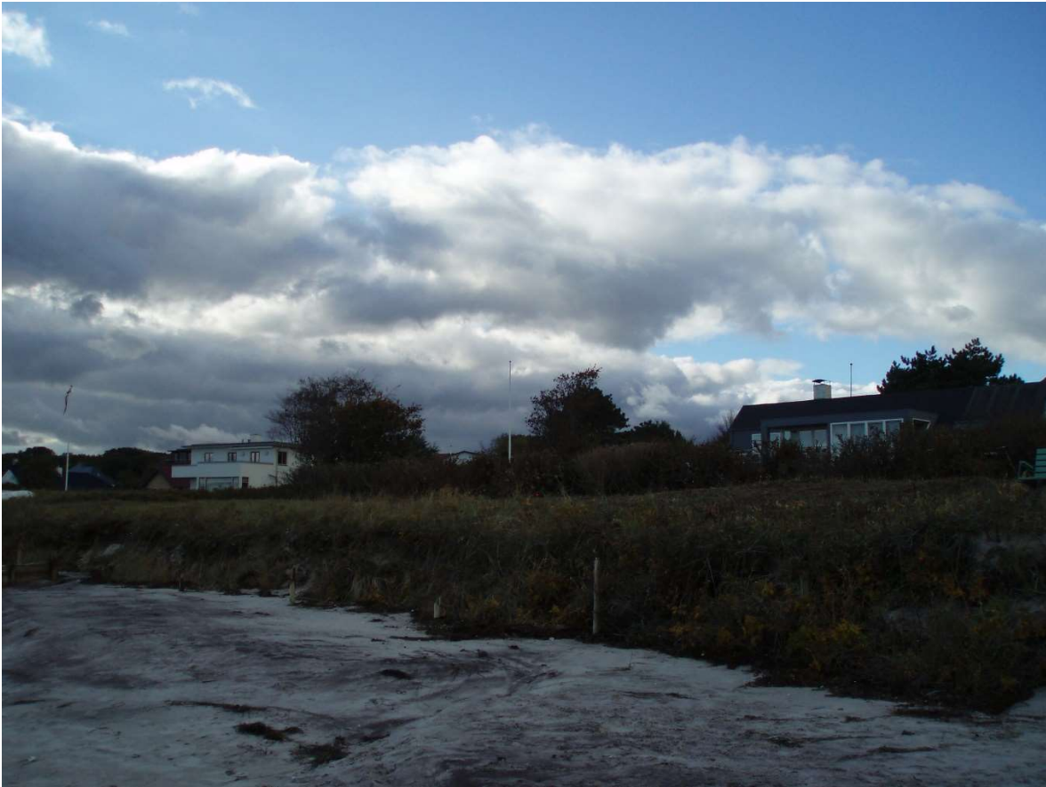
(7) Hyldevej , niveau af stranden som for år tilbage ikke eroderet dybere, se det gamle spil. Vi er tæt på digefoden.
