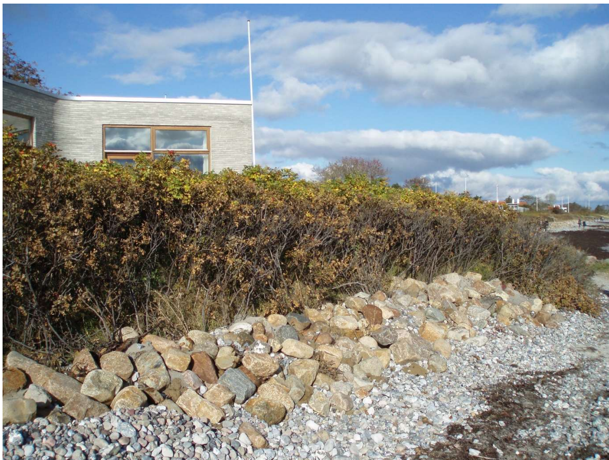
(3) "Pynten" ved Platanvej mod Strandvænget med anlagt stenbeskyttelse.
