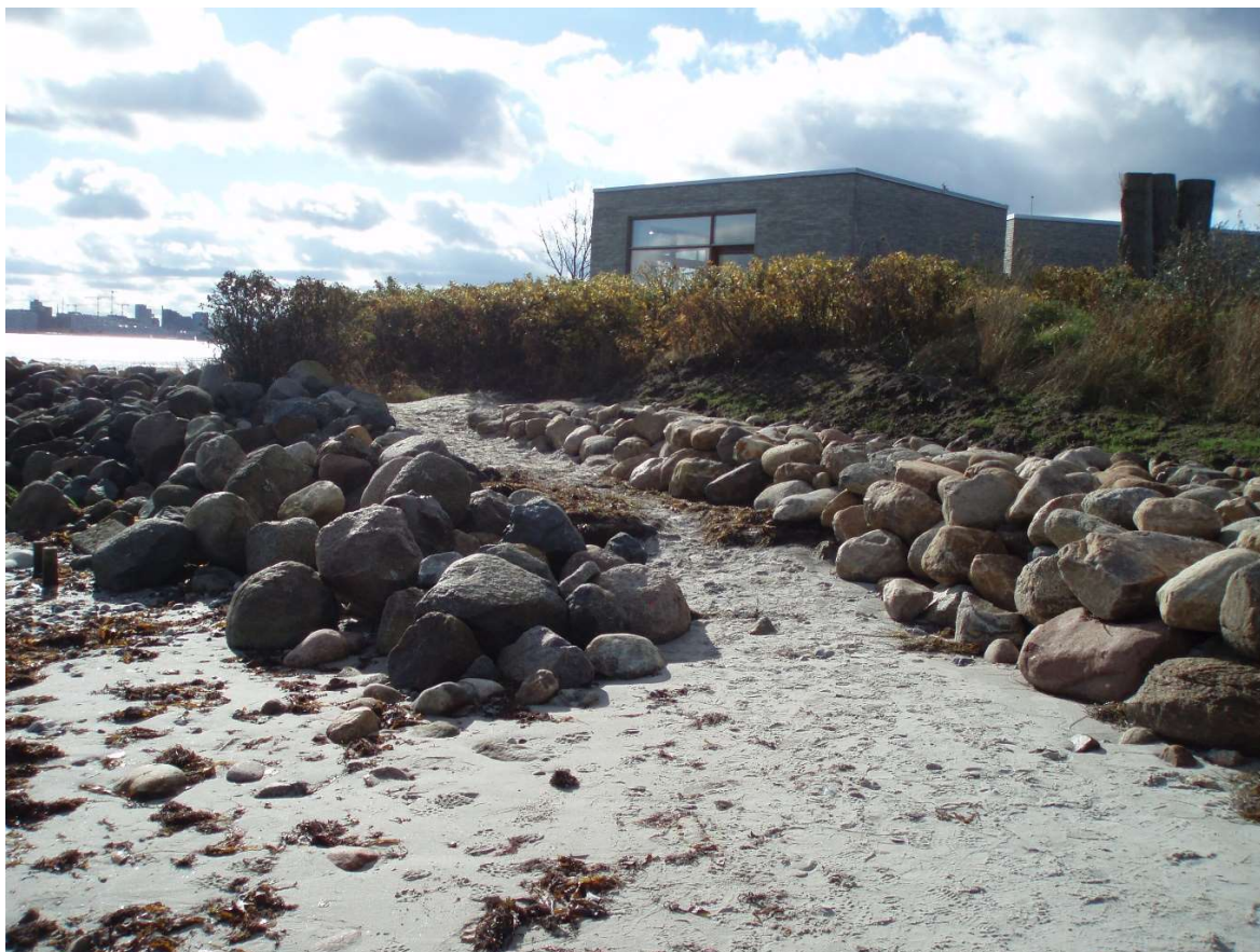
(5) Platanvej med anlagt god stenbeskyttelse. Der er god og fungerende passage omkring "pynten".
