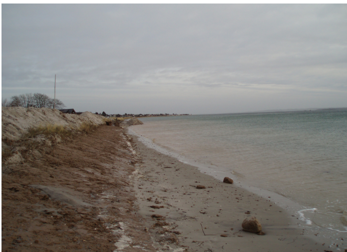
Ved 80 cm højvande når vandet op til digereparationen
