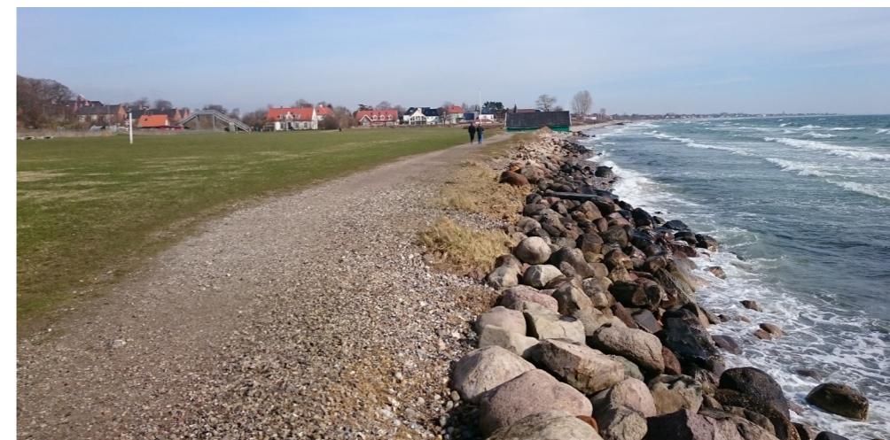
Fig. 10: Skråningsbeskyttelse af marksten, der skal beskytte mod nedbrydning af kysten
