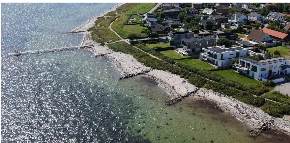
Fig. 8: Høfder ved Badevej
